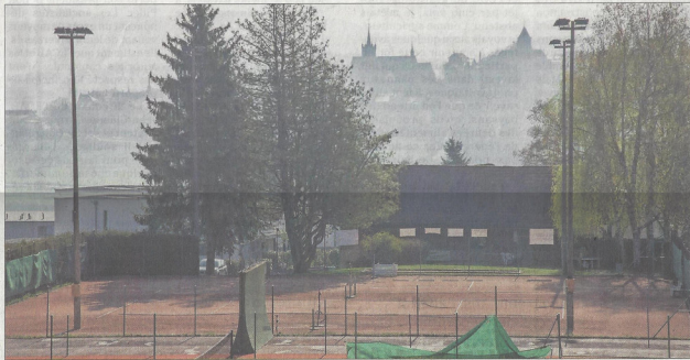
«Tout est prêt pour la mise à l'enquête», déclare le syndic Dominique Butty, au lendemain du oui à la rénovation du centre sportif. ARCH - A. VILLIQUO
